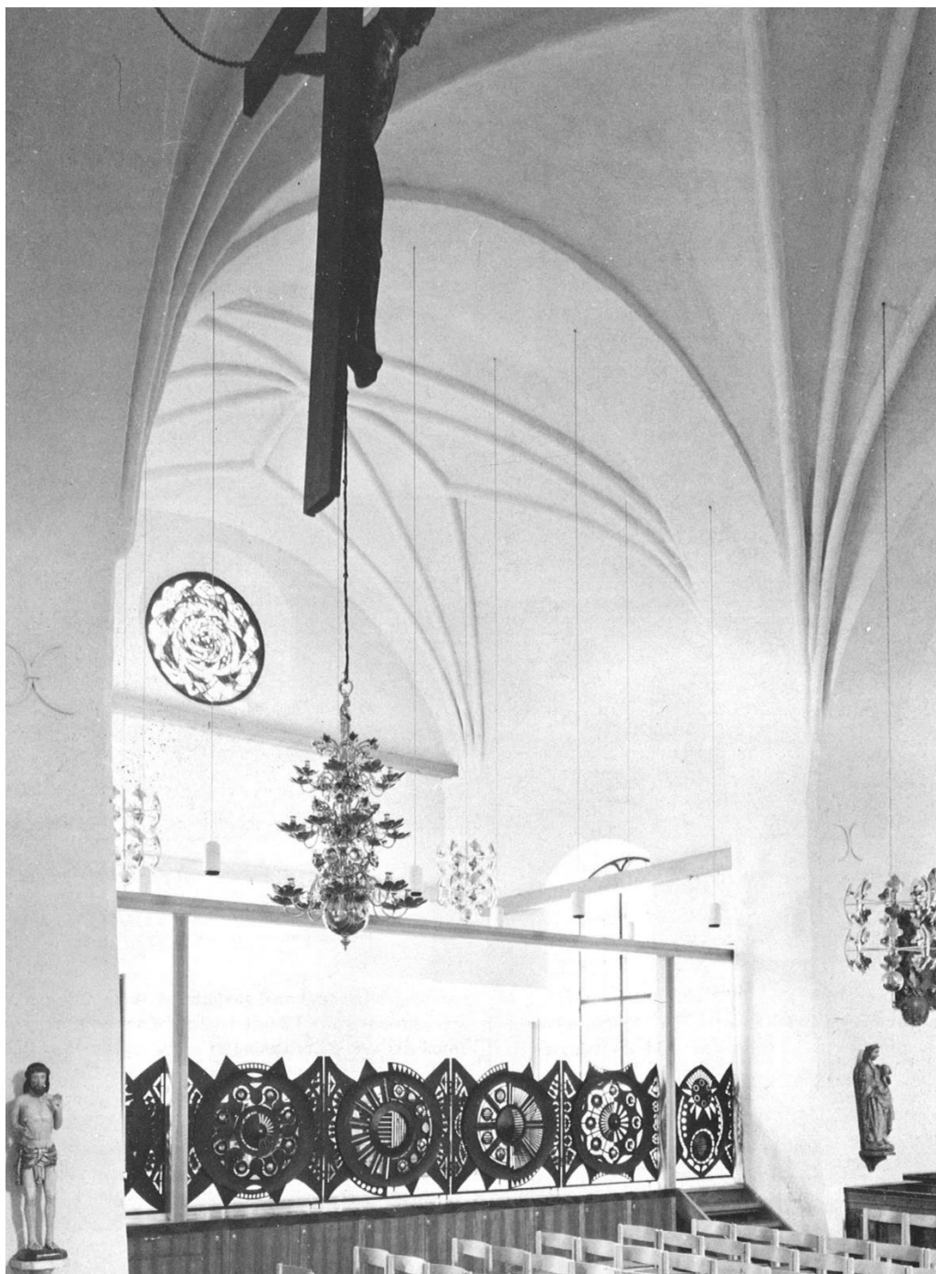
Körestraden i södra korsarmen 1972.
