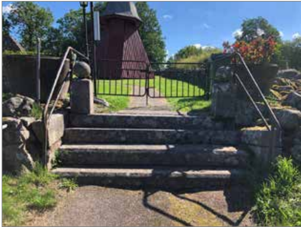
Trappa, grind och grindstolpar vid kyrkogårdens västra entré.
