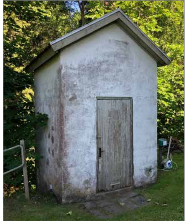
Den före detta transformatorstationen norr om kyrkan.
