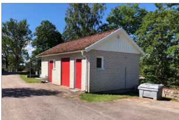
Ekonomibygnaden på kyrkogårdens norra del.
