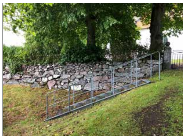
Trappa av metall vid den södra entrén.
