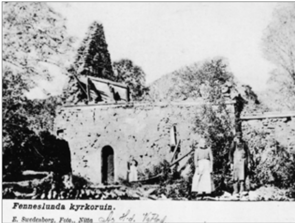
Fänneslunda ruinkyrka tidigt 1900-tal. Källa: Riksantikvarieämbetet.
