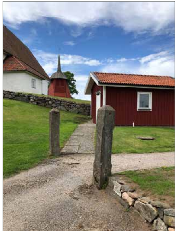
Ekonomibyggnaden från nordost.
