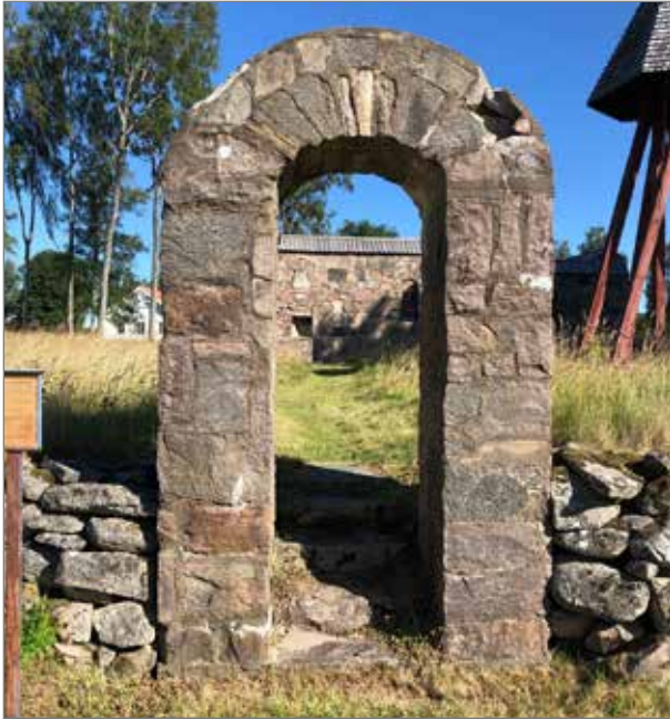
Stigluckan vid entrén i söder.
