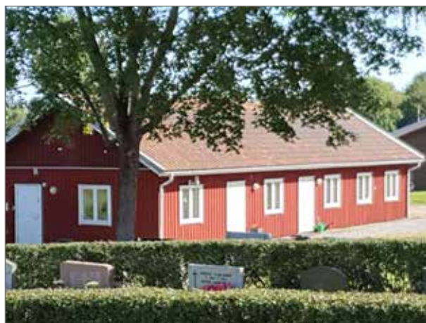
Ekonomibygnad nordost om kyrkan intill parkeringen.
