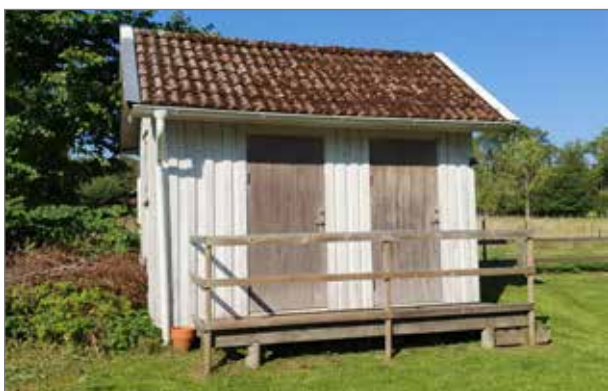
Ekonomibyggnadens östra fasad.
