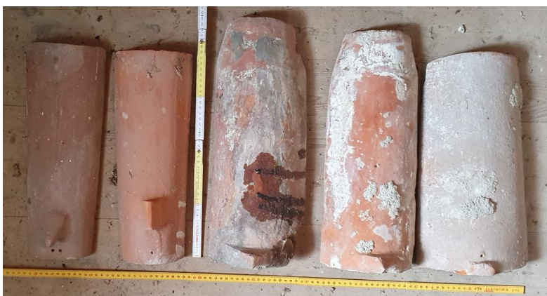
Olika typer av munk- och nunnetegel på Falsterbo kyrkas vind. Th vingtegel på långhusvinden.
