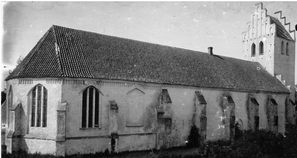
Foto av Otto Rydebäck år 1900 där det tycks som större delen av norra takfallet är belagt med munk- och nunnetegel.
