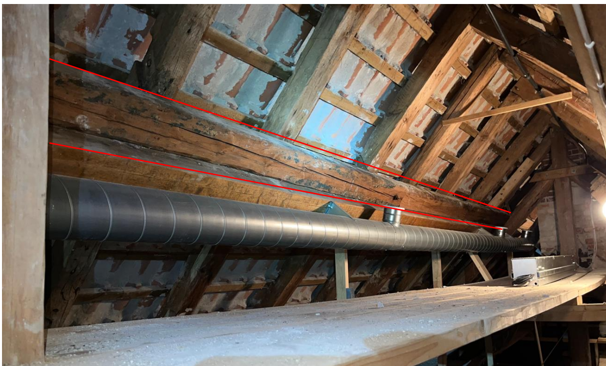
Figur H. Deformationer i åsarna och limträbalkarna parallellt takytans plan.
