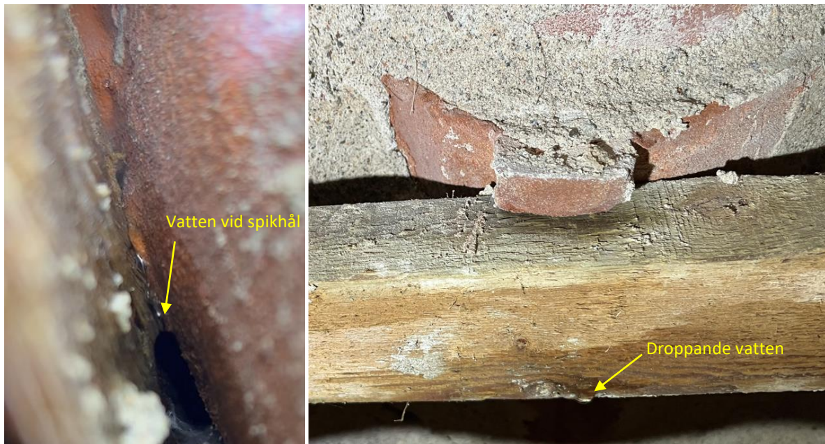
Figur a. Överst, nunnetegel med spikhål, överlapp från täckande nunnetegel markerat. Nere vänster, foto taget uppåt mellan läkt och nunnetegel. Vid kraftigt regn sögs vatten in genom spikhål. Nere höger, nunneteglets upplag på läkt. Vatten droppar ner från läktet vid kraftigt regn.
