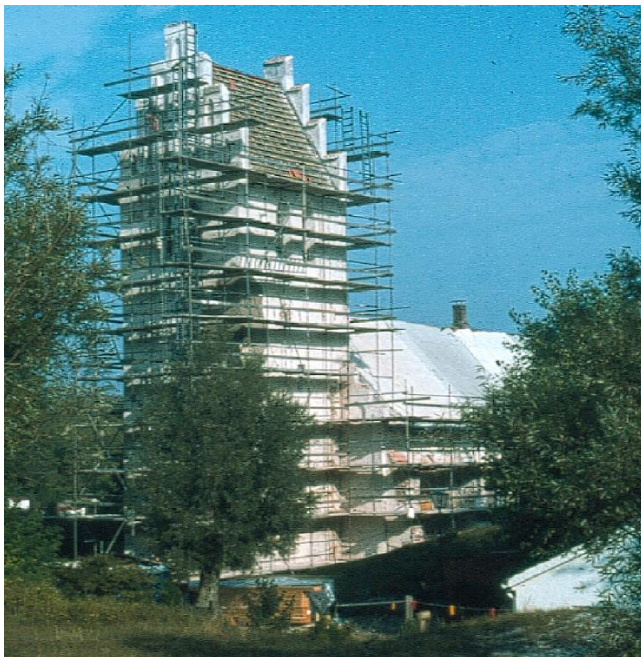
Falsterbo kyrka vid renovering 1979-80.
