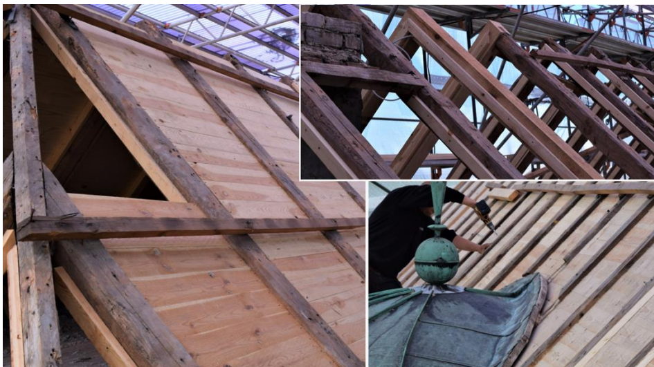
Princip för försänkt underbrädning mellan takstolar. Foto från arbeten i Danmark.
