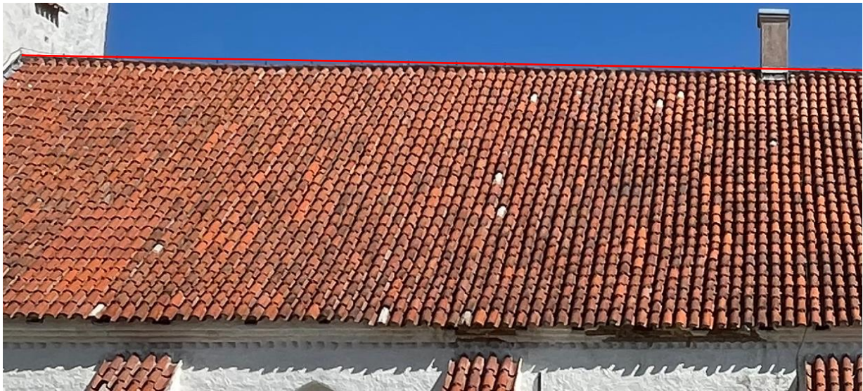
Figur G. Deformationer i konstruktionen. Observeranocklinjens svackor gentemot inritade raka röda linjer.
