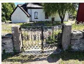
Grindpartiet i norr.
