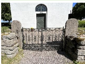
Grindpartiet i väster.
