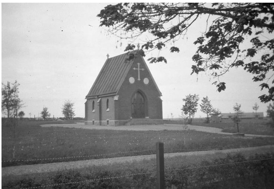
Tidigt 1900-tal (okänt årtal), vy över det nyligen utvidgade området med det nybyggda gravkapellet i mitten. (Östergötlands museum, Digitalt museum)
