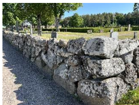
Mur i nordväst (t v) och väst (t h)
