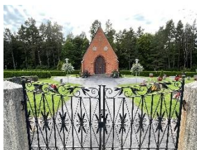
Asfalt framför gravkapellet
