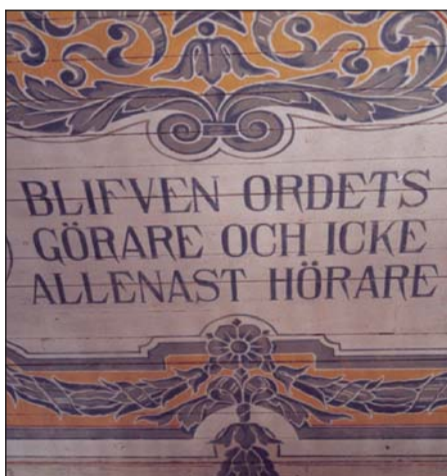
Rämmens kyrka genomgick en omfattande renovering 2005. Då togs också de tidigare övermålade, gamla takmålningarna fram.
