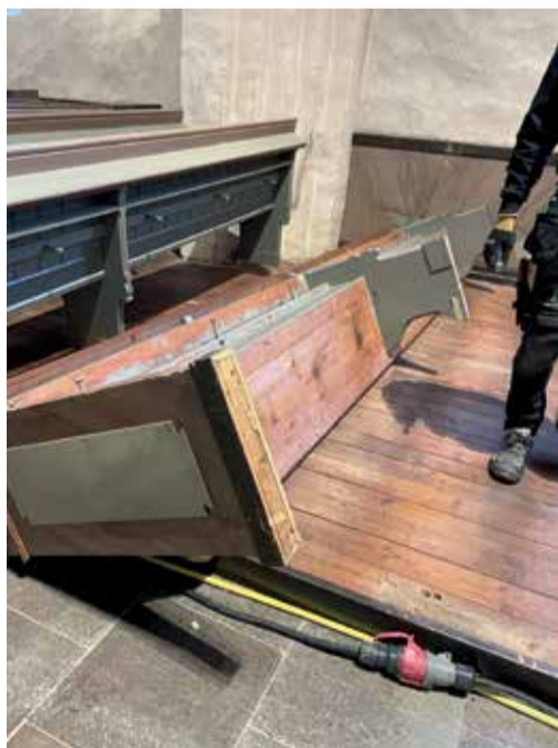
Bänkarna var fastspikade i golvet och varsamt sågades spikarna loss för att inte skada kyrkbänkarna.
