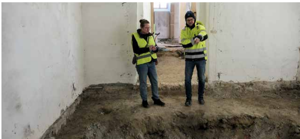
Conny Lundell är platschef för kyrkans renoveringsarbete. Här visar han för församlingens kommunikatör hur de under arbetets gång hittat en tidigare kistförvaring som var igenfylld med betong i södra entrén.
