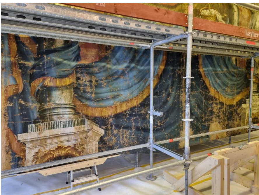
Ovan bild. Efter åtgärd.
