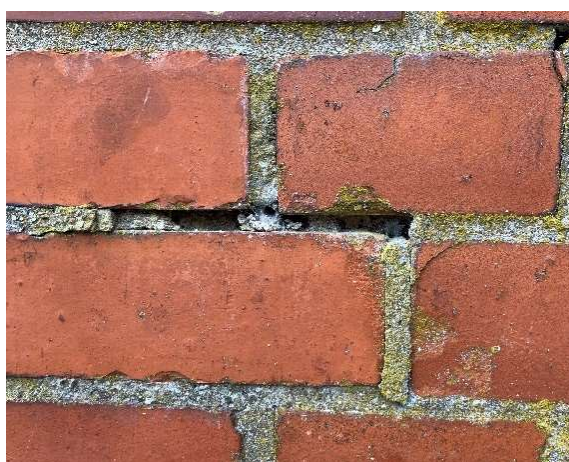
Figur 2.1 Skadat fogbruk i nygotisk kyrka.
