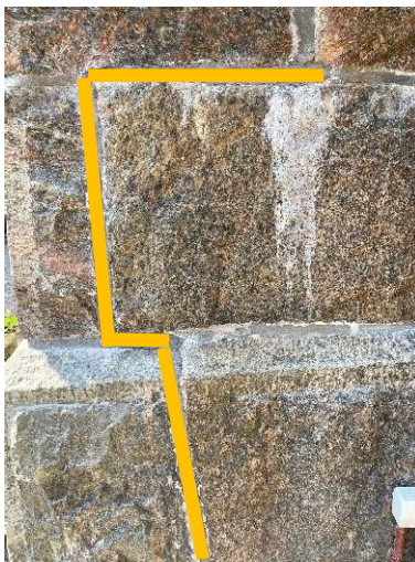
Placering fogbruk 7: våtsläckt Trilokalk.
