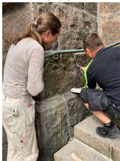
Figur 3.4 Applicering av fogbruk genomfördes av Lörinc Kurko, augusti 2022.
