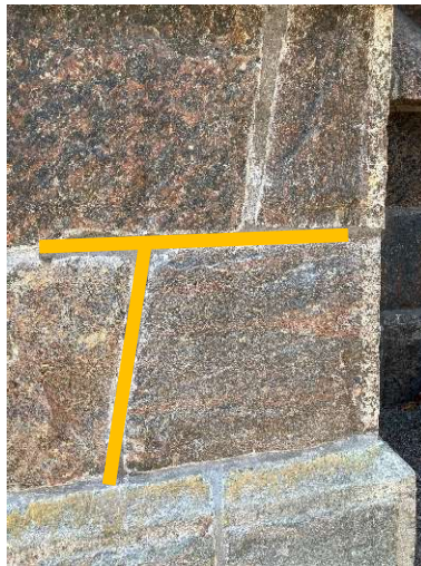
Placering fogbruk 9: Trilo/Ortokalk 50/50.
