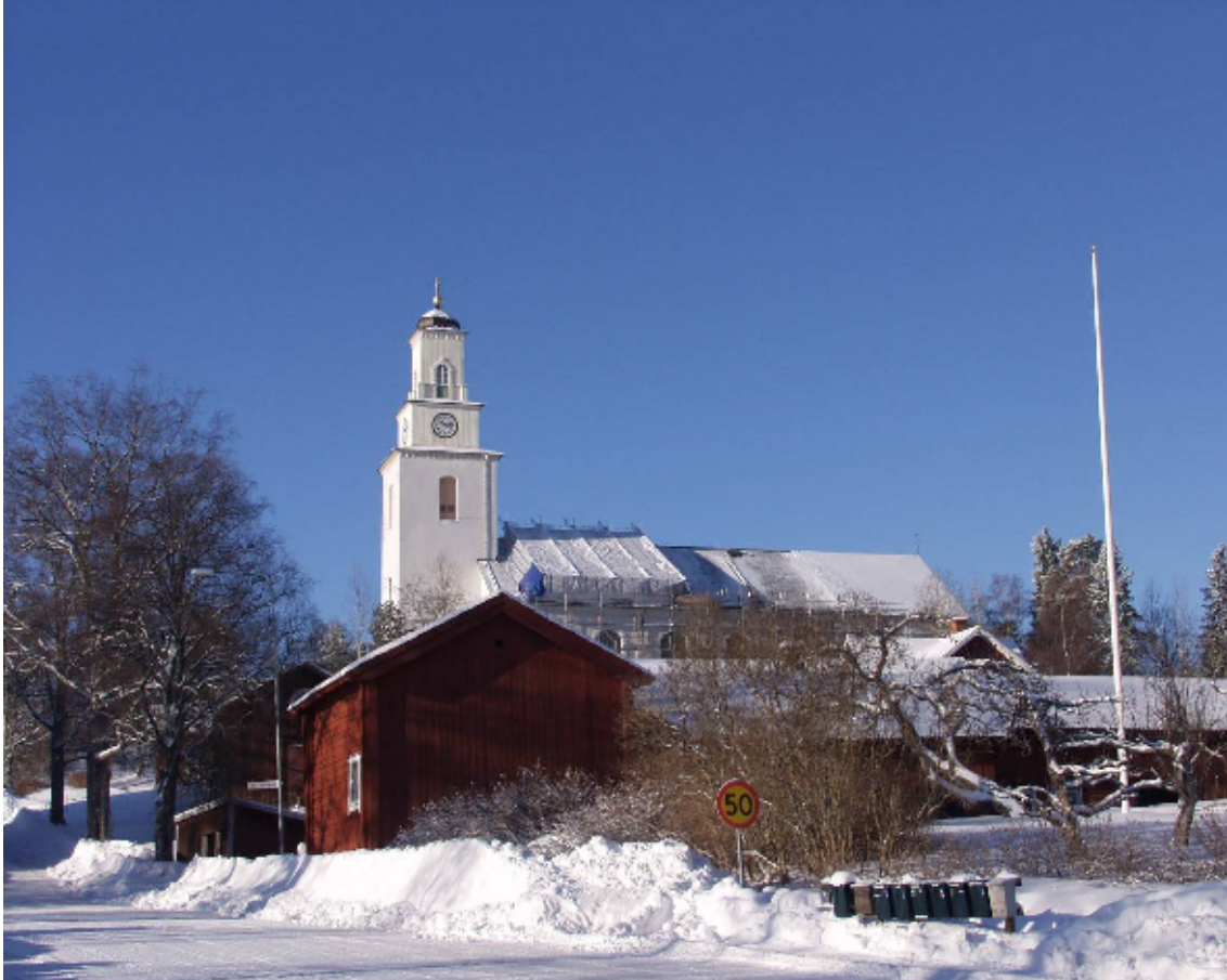
Boda kyrka i februari 2006, då omläggning av östra takfallet pågick - Digitalfoto Rolf Hammarskiöld
