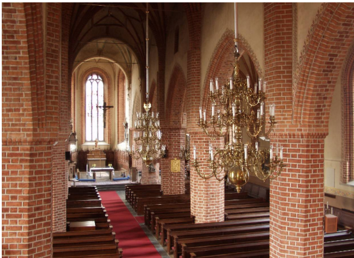
Kyrkorummets gestaltning präglas i hög grad av arkitekten Gustav Petterssons insatser 1899-1901. Då frilades valvpelarnas tegelmurar och nya fönster- och portomfattningar murades. Kalkstensgolv lades, mörkfernissade inredningssnickerier byggdes och dekorationsmålningar utfördes av Theodor Pettersson. Ljuskronorna från 1600- och 1700-talen elektrifierades. Digitalfoto Rolf Hammarskiöld
