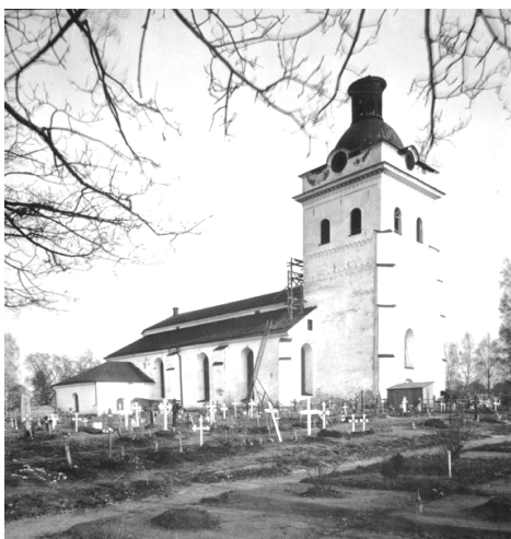
Stora Tuna kyrka från nordväst, före restaureringen 1914-1915
