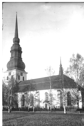
Kyrkan från sydöst, efter restaureringen och med nya spiran
