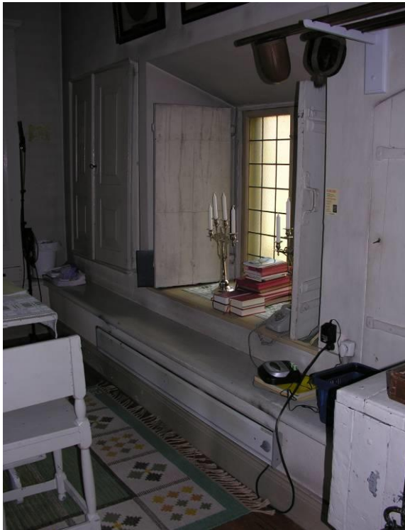
Sakristian från 1842 har ursprunglig väggfast inredning. Valvet på järnbalkar blev däremot slaget 1898, därför att det ursprungliga innertaket varit försvagat alltsedan kyrkbranden 1852. Möbleringen är från 1906. Digitalfoto Svensk Klimatstyrning AB
