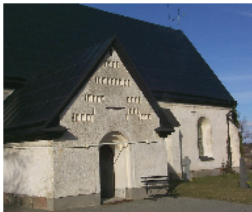
Södra vapenhuset är sedan 1680 sammanbundet med dragjärn. Kyrkans yttertak plåttäcktes 1894/möjligen något senare på 1890-talet. Digitalfoto Svensk Klimatstyrning AB
