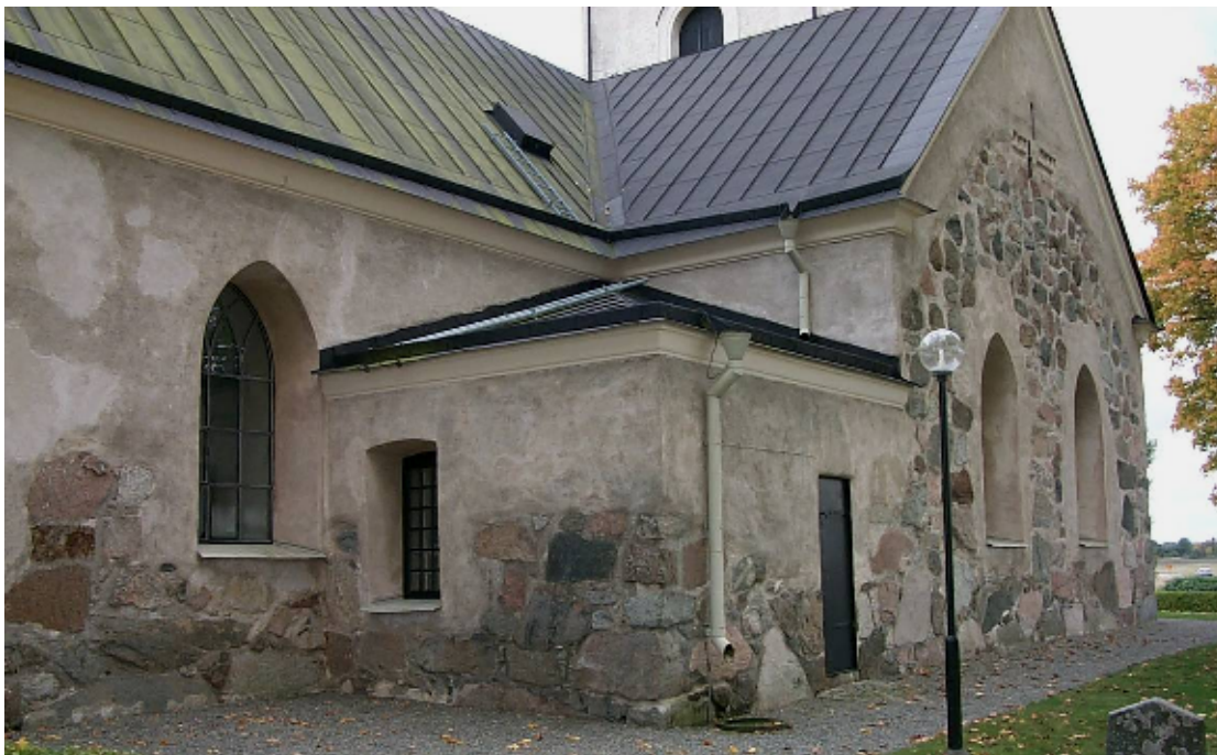
Kyrkans norra sida; gråstensmurarna har varit blottlagda sedan en stor yttre upprustning 1925-26, ledd av arkitekt Viktor Segerstedt. Senare förslag om att åter slå på fasadputs har inte vunnit bifall. I korsarmens norra gavel ses spår av en medeltida blinding - Digitalfoto Svensk Klimatstyrning AB
