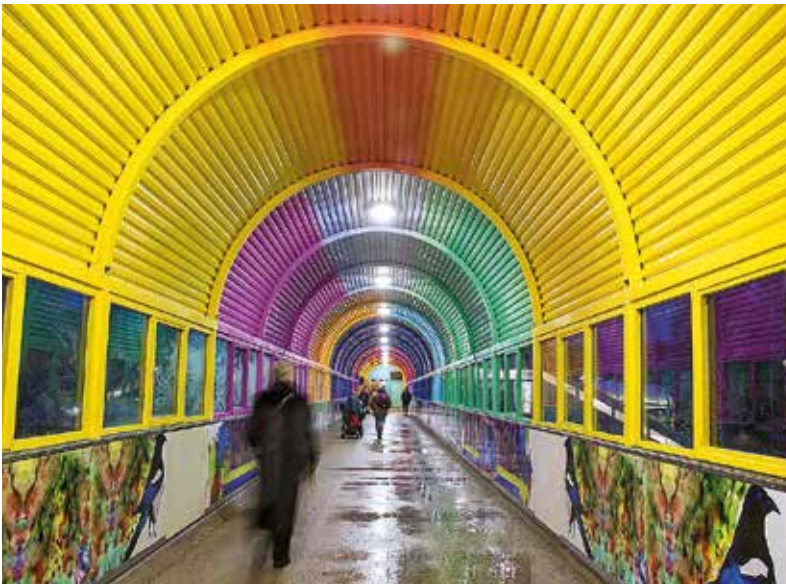
Vandra genom regnbågen. Konstverket som Valeria gjort i gångtunneln till Handens pendeltågsstation heter En dans på rosor. Gångtunneln är 65 meter lång och passerar av många människor varje dag.
