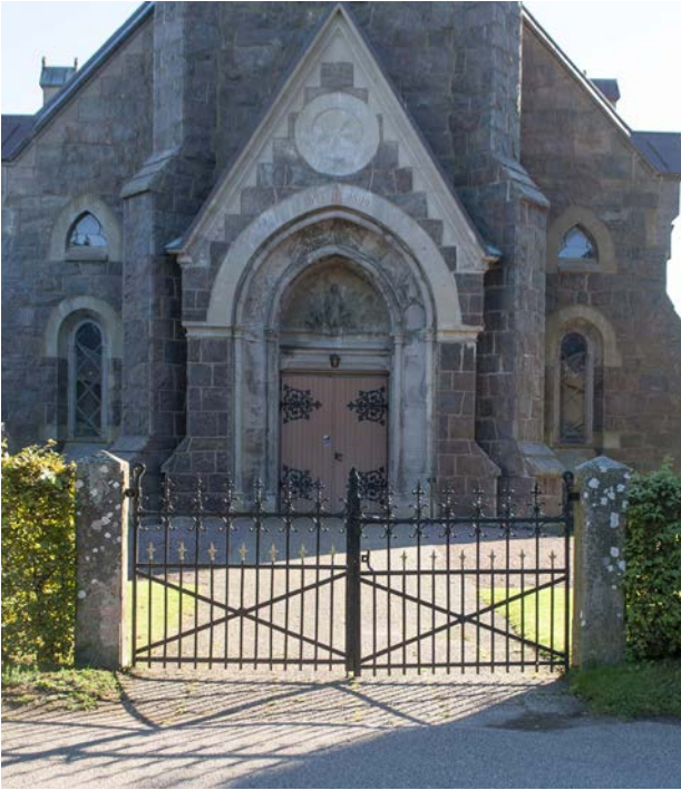
Smidesgrinden vid den västra ingången.
