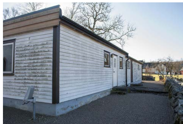
På baksidan syns det att ekonomibyggnaden är tillbyggd, troligen mot norr.
