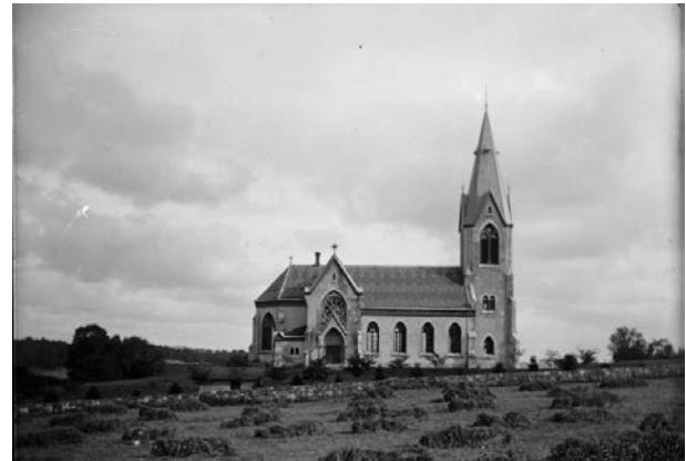
Köinge kyrka 1918. Kyrkogården sluttar brant ned mot väster där det ligger en liten ekonomibyggnad vid muren. Foto: Sigfrid Gunnäs, Kulturmiljöbild, Riksantikvarieämbetet.
