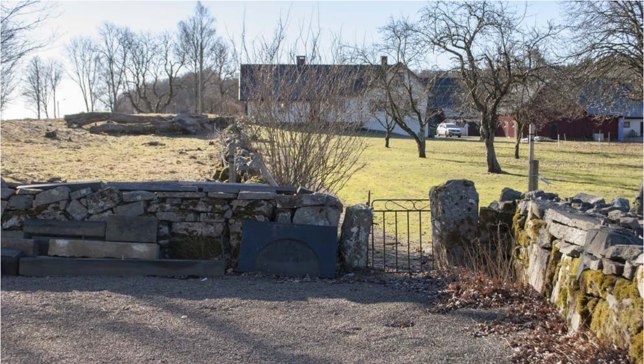
Även i kyrkogårdens sydvästra hörn finns en liten smidesgrind. I de västra delarna av kyrkogården ligger muren som en skalmur ovan jord.
