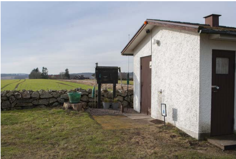
Serviceplatsen vid ekonomibygnadens södra gavel.
