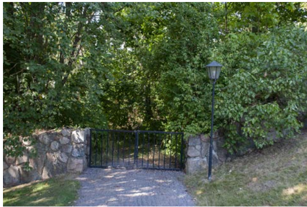
Den yngsta delen ramas in av en murad skalmur. I väster finns en pargrind.
