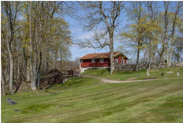
Ekonomibyggnadens baksida, ovanför komposterna i sluttningen i kv. 4.
