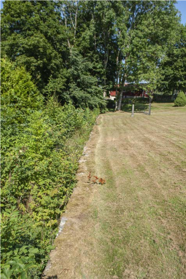
Den södra delen kantas av en stödmur mot väster. Muren är nästan helt dold av växtlighet. lövdungen på sluttningen bidrar till en grön inramning.
