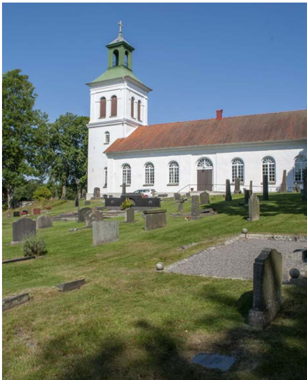
Den södra utvidgade delen.
