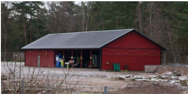
Ekonomibyggnaden i västra delen av kyrkogården är utformad som en traditionell lada men med detaljer som kryssmotiv.
