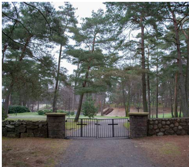
En bred pargrind mot skogen i söder. På den östra sidan ansluter den äldre bruksmuren och mot väster finns en något yngre kallmurad mur.
