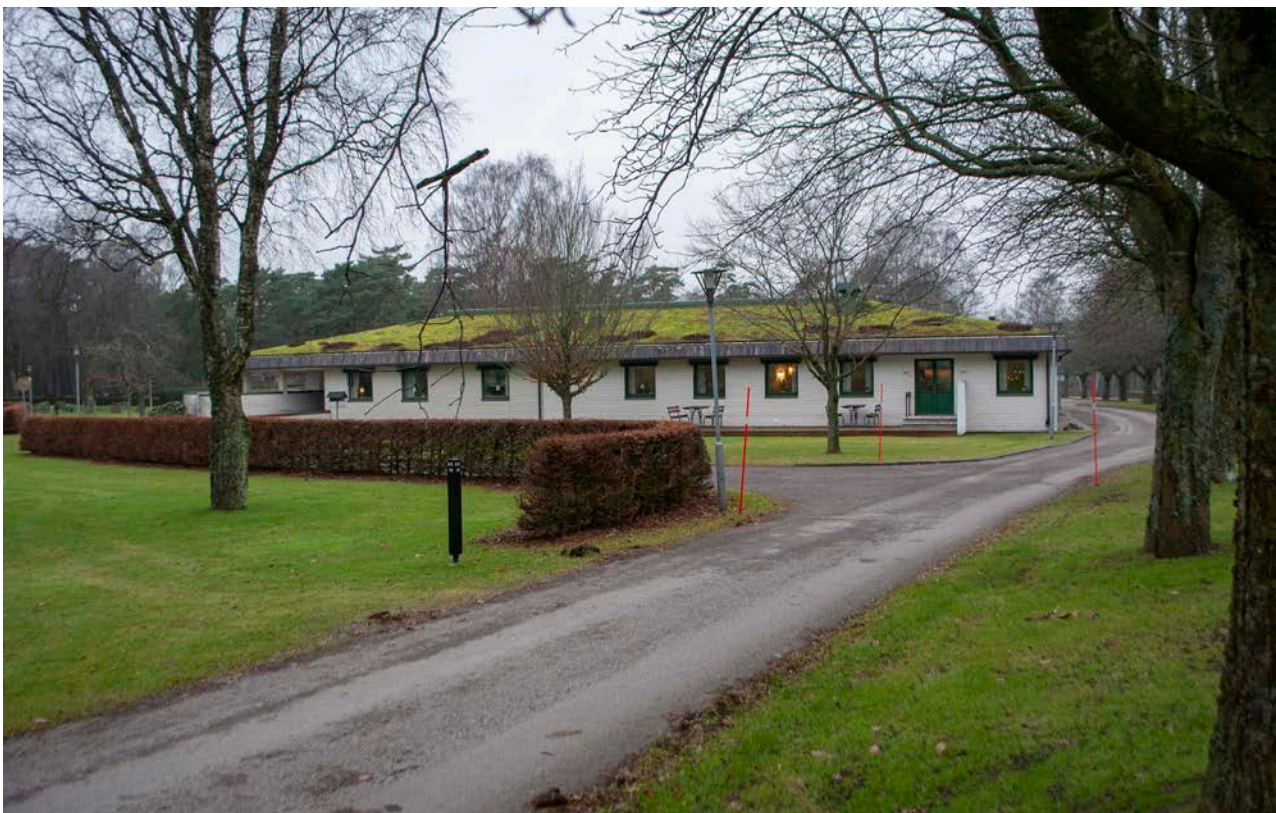
Personalbyggnaden sedd från öster.
