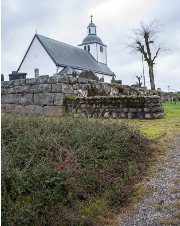
Runt den utvidgade delen finns en murad mur av runda fältstenar med breda fogar, typisk för 1960-talet.
