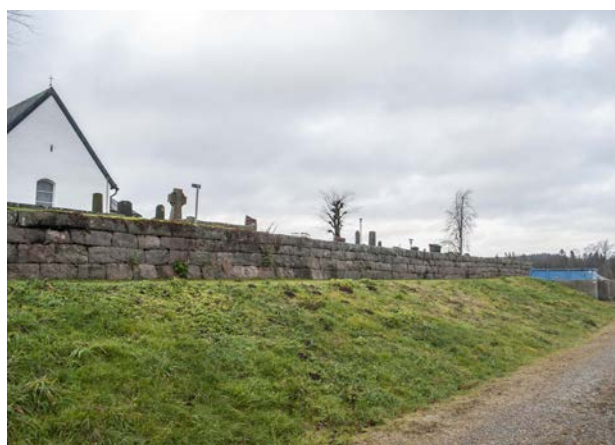
Mot öster finns en lägre stödmur ovanför en grässlänt.
