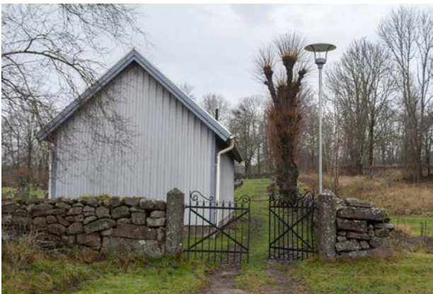
Öppning med smidesgrind mot söder, vid ekonomi-byggnaden.
