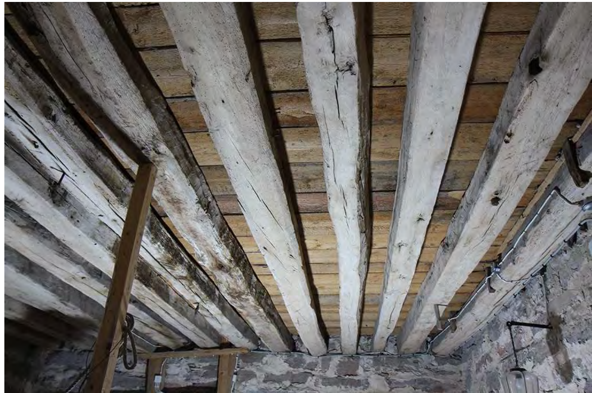
Bredsättra kyrka Bjälklag i torn, 1200-tal
