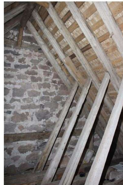
Korets takkonstruktion, foto C Thelin
