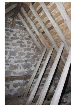
Korets takkonstruktion
