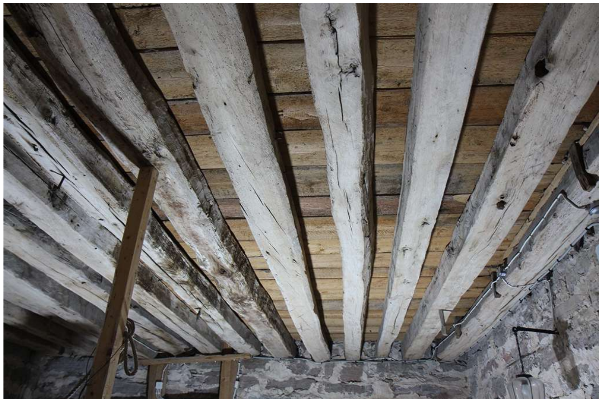
Bredsättra kyrka Bjälklag i torn, 1200-tal
