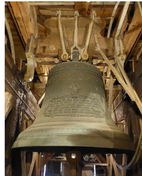
Das hat mit der Zeit nicht nur zu einem blechernen, grellen Klang geführt, sondern auch zu Schäden bis hin zu Bruchgefahr. Aus diesem Grund läuten wir die kleinste Glocke momentan gar nicht mehr.
