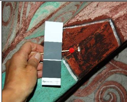
Fig. 46 Ett exempel på plats, valvribba, där orange blymönja täcks av ett tunnare lager röd cinnober. Prov 8.
