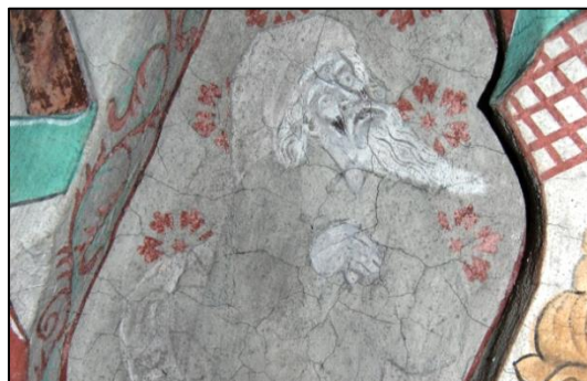
Fig. 4 Västra valvet, västra kappans södra del. Före rengöring. Både huvudbonad och dräkt upplevs som smutsgrå, lika bakgrunden. Dräkten har dock tidigare varit blå. Små rester som finns kvar i håligheter och porer är tydliga i mikroskop. Huvudbonaden kan ha varit röd.
