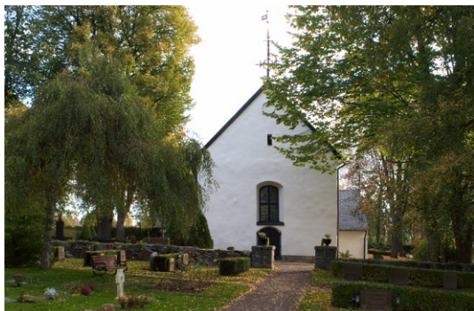
Exteriör med entré från väster.
