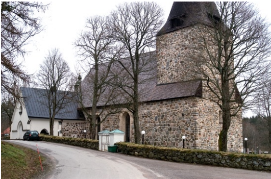
Kyrkobyggnaden från nordväst.
