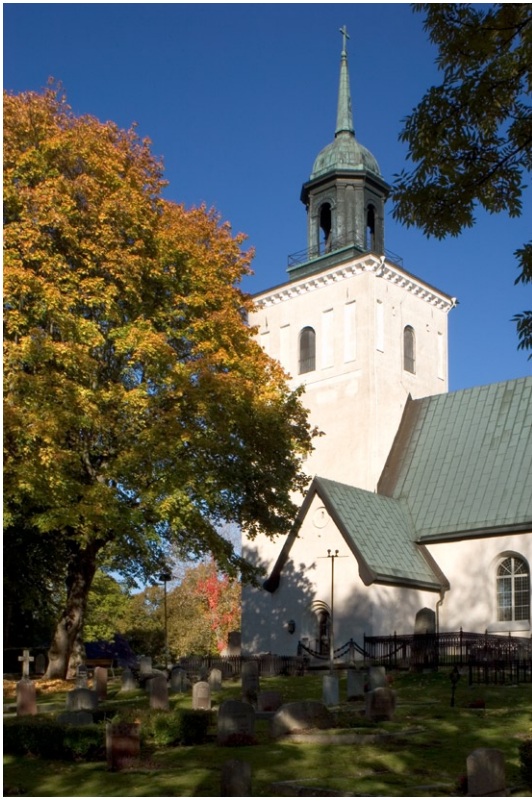
Torn, vapenhus och del av långhus mot söder.
