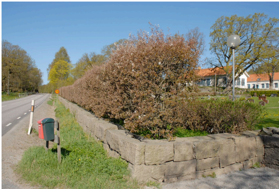
Bild 33 Nya delens mur mot söder
