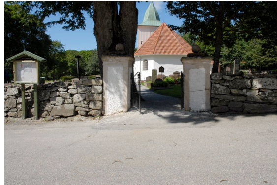
Bild 30 Grind i östra muren
