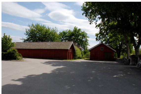
Bild 43 Äldre ekonomibyggnad till höger
