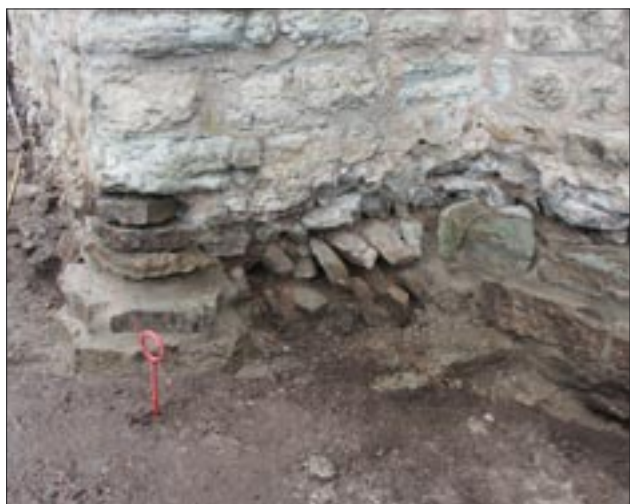
Fig 42. Stenkilska gravkoret, grundmur med kantställda kalkstenar, sydöstra hörnet mot väster (U4719:18).
