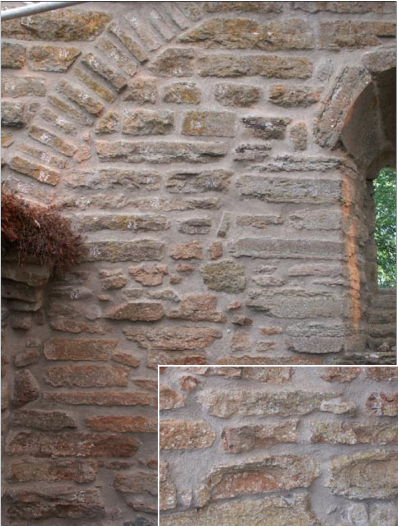
Fig 14 A–B. Parlatoriets östra mur, fotat i släpljus, markerade stenar är rekonstruerade på 1920-talet och försedda med tydligt RK. De har en blåaktig ton, medan originalstenarna har en lätt rödaktig färg, samt tydliga musselformade spår av brand (U3642:331 och 334).
