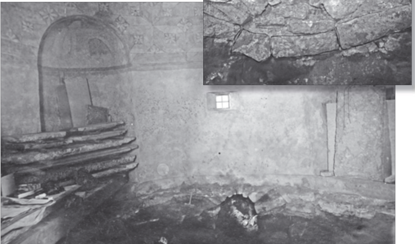
Fig 51. Stenkilska gravkoret, foto från 1919 i samband med undersökningen av kungagravarna. I västra muren syns tydligt det murade och vid detta tillfälle frilagda valvet (ATA). Infälld bild ovan t h: Närbild av det murade valvet före friläggning (ATA).
