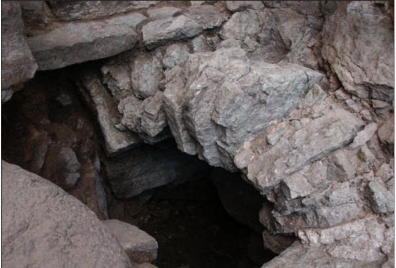
Fig 49. Stenkilska gravkorets västra grundmur, med ett murat valv i norra delen (U4719:49).
