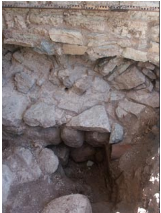
Fig 48. Stenkilska gravkorets västra grundmur, med ett murat valv i södra delen (U4719:63).
