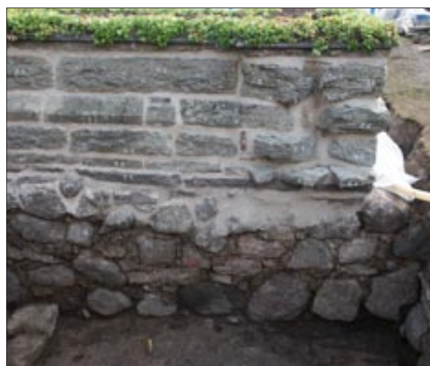
Fig 38. Källare (5), östra muren med anslutning till köket (U3642:100).
