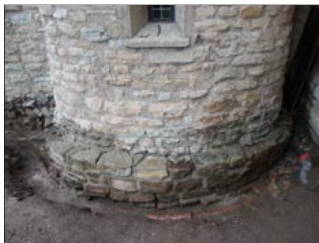
Fig 41. Dito bild efter grundmurens renovering (U4719:23).
