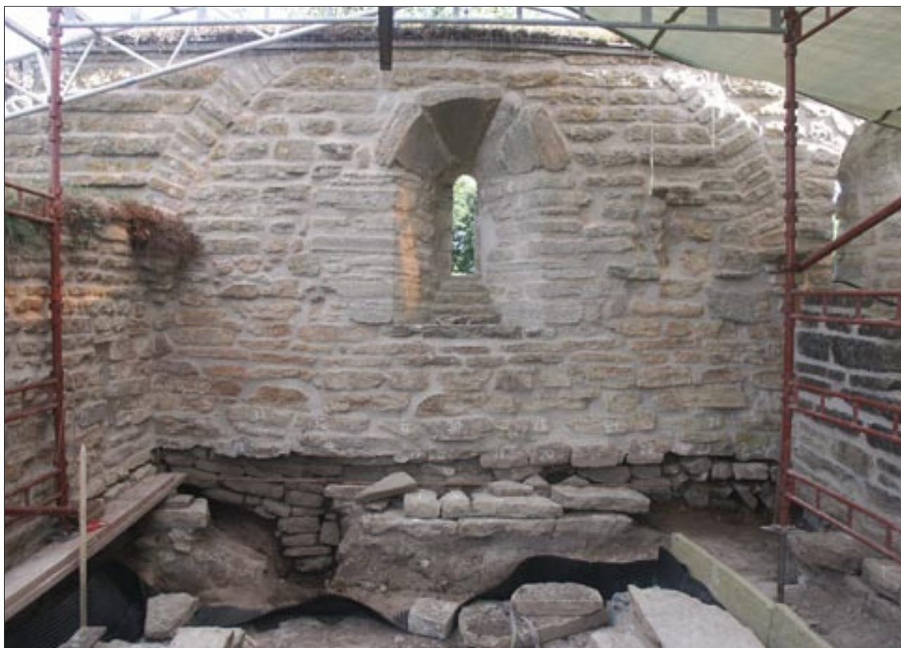
Fig 11. Parlatoriet mot öster. Under den klosterida östmuren hittades rester av en äldre östmur, sannolikt till en äldre byggnad (U3642:329).
