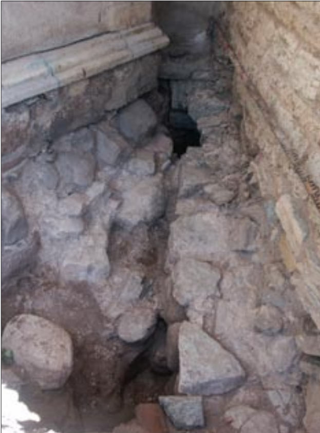
Fig 47. Stenkilska gravkorets västra grundmur frilagd, med grundmuren till Douglas gravkor till vänster. Längst mot norr framträder det norra murade valvet (U4719:68).
