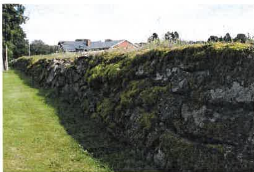
Sydvästra muren av huggen sten och fältsten.
