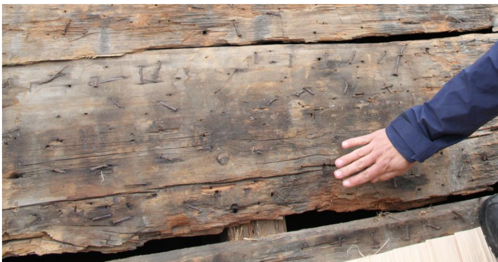
Vid byte av takspån gjordes en spännande upptäckt. Det visade sig när kyrkan byggdes återanvändes bräder från en kyrka byggd på 1100-talet. Foto: Maria Eddebo Persson
