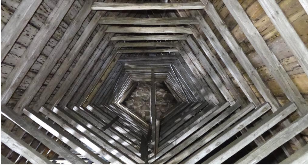
Växjö stift har genomfört inventering av medeltida takbjälklag Lekaryds kyrka som har takbjälkar i fur från 1500-talet. Enligt inventerarna består takstolarna av högben, knäbock med stickbjälke/tass och stödben, två hanbjälkar, saxsparrar som möter stickbjälke/tass, och två murremmar per sida. Foto: Mattias Hallgren
