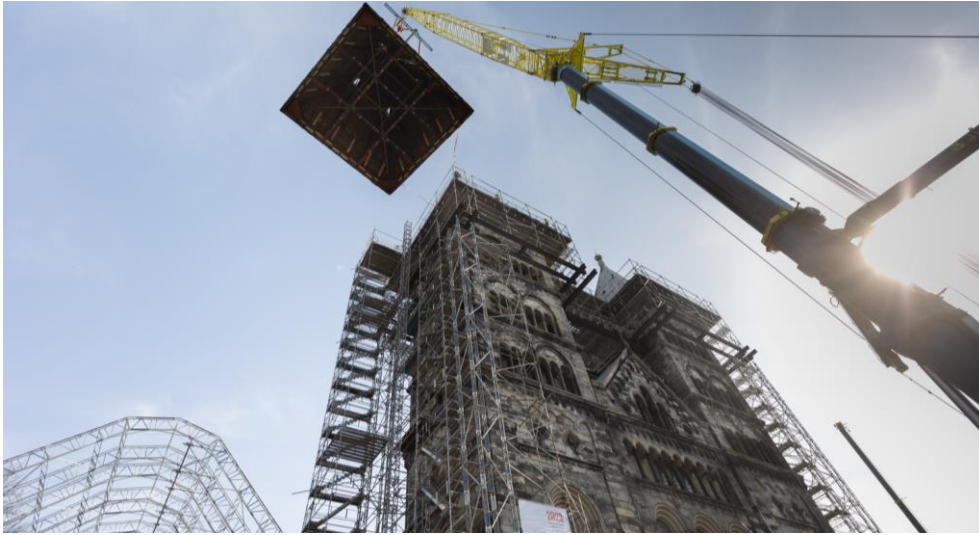
Tornhuvarna på Lunds domkyrkas torn lyftes av för renovering under 2022. Foto: Gunnar Menander
