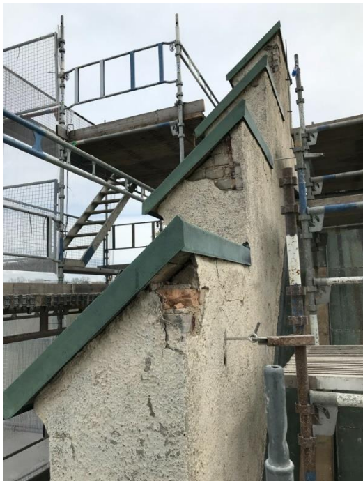
Bild från före renoveringen av fasad och tak på Höörs kyrka
