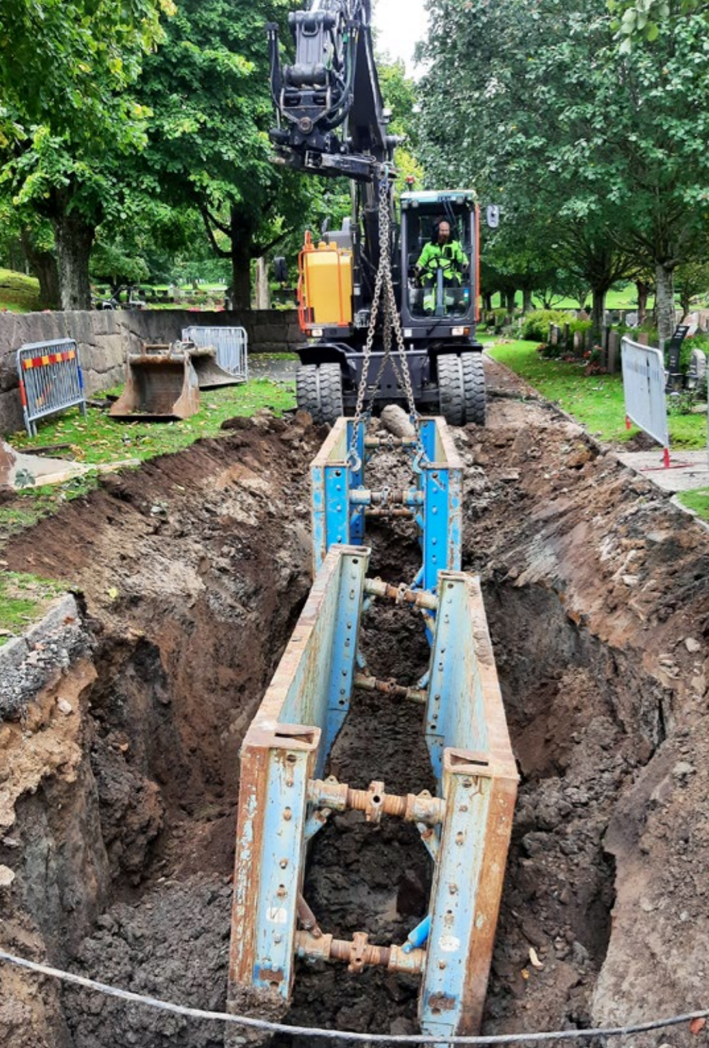
Till vänster: När anläggningslaget grävde upp ett slukhål visade det sig att rördelar glidit isär och det blev ett större arbete som uppmärksammades i medierna. Överst: Fönster renoverades och i kapellet på Mariebergs kyrkogård går det nu även att öppna det mindre fönstret. Ovan: Carl Byhlin bekämpar jättebjörnloka med lie på Kvibergs kyrkogård.
