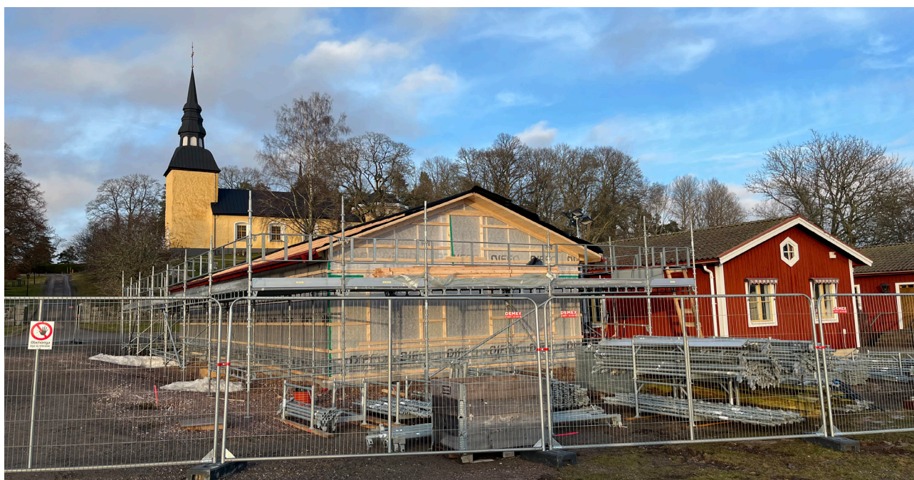
Byggnationen för om- och tillbyggnaden börjar ta form.
