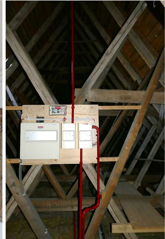
Brandlarmet är ett samplande system där den största installationen görs från vinden. I kyrkorummet märks installationen minimalt. Bilden ovan till höger visar del av systemet på vinden. Till höger i bild syns även en av de gångbryggor som tillkommit under den senaste underhållsperioden.
