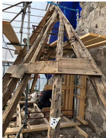
Absidens koppartak och stödplankor inunder har tagits ner. Borrkärnor från bjälkarna visar att en del av dem är från 1100-talet.
