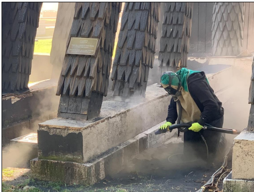
Renovering av S:t Laurentii klockstapel.
