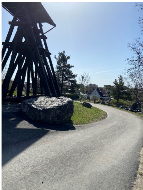
Ny asfalt har lagts vid kyrkan och klocktornet.
