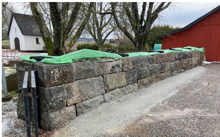
Partiell lagning av muren har genomförts vid Säby kyrkogård (redovisas under begravningsverksamheten).
