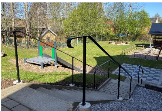
På baksidan av S:t Larsgården har nya ledstänger satts upp vid trappan.
