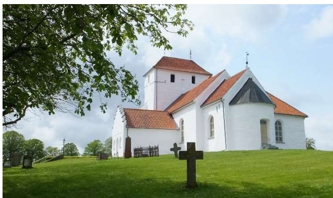
Kyrkan sedd från sydost.
