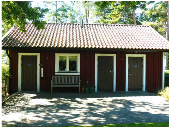
Kyrkogårdsförvaltningens byggnad vid parkeringen väster om kyrkogården.
