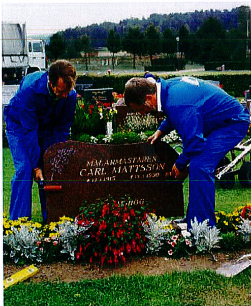
Gravvård monteras på synlig sockel efter grundläggning.
