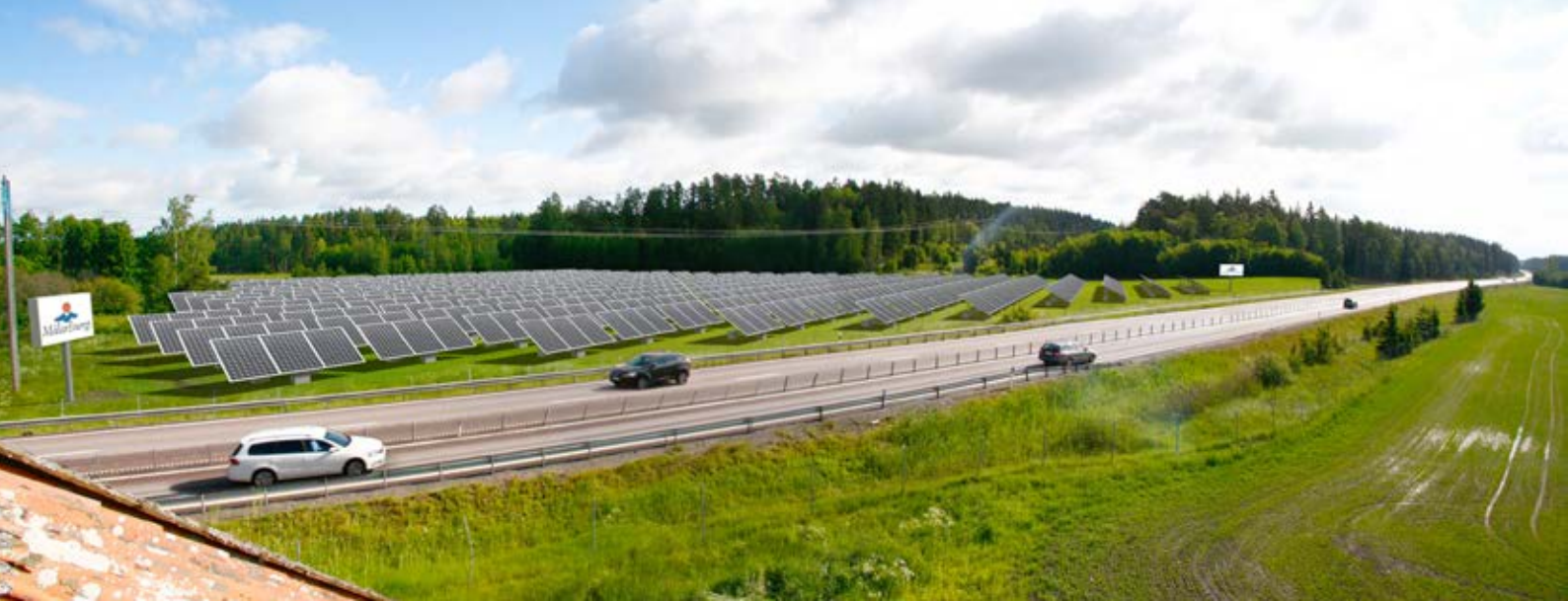
Bilden är ett montage som visar den solcelspark som just nu byggs vid sidan av E18 i Västerås av Kraftpojkarna. Foto & montage: Kraftpojkarna.
