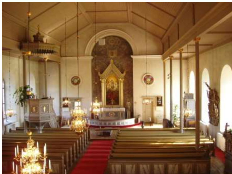
Kyrkorummet i Västra Ryd från 1882 är representativt för eklekticismen kring 1800-talets mitt. Här finns såväl nyklassicistiska som nygotiska element. Karaktäristiskt är det s.k. tredingstaket som här stöts av gjutjärnskolonner.
