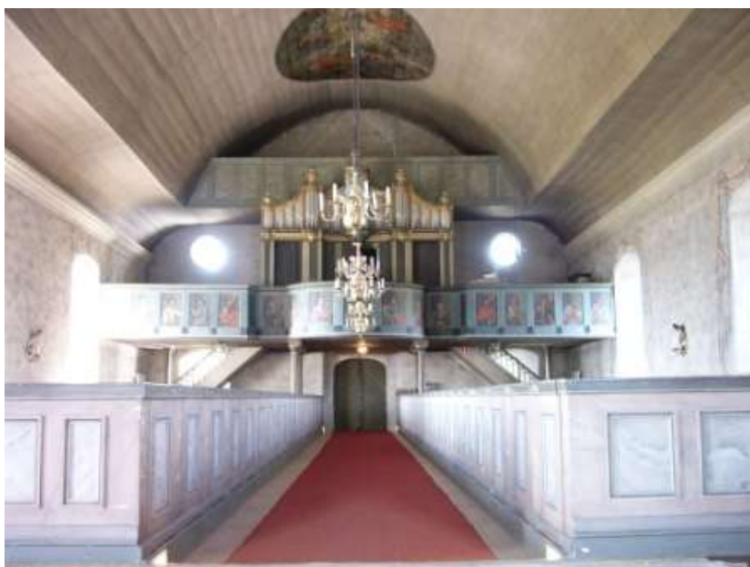
Kättilstad kyrka förmedlar en stark känsla av autenticitet genom sina ålderdomliga ytskikt. Unik i dag är den lilla läktaren ovanför orgeln.
