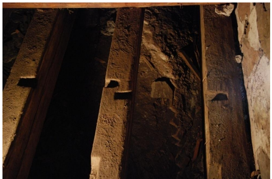
Fig. 5: Urtagningar för två klockor i långhusets östligaste bindbjälkar. Nederst i bild skymtar urtagningarna för de borttagna högbenen.
