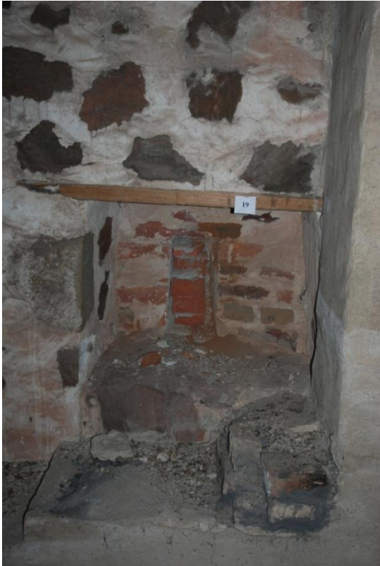
Fig. 11: Sakristians övervåning, förvaringsutrymme med inmurad överliggare.
