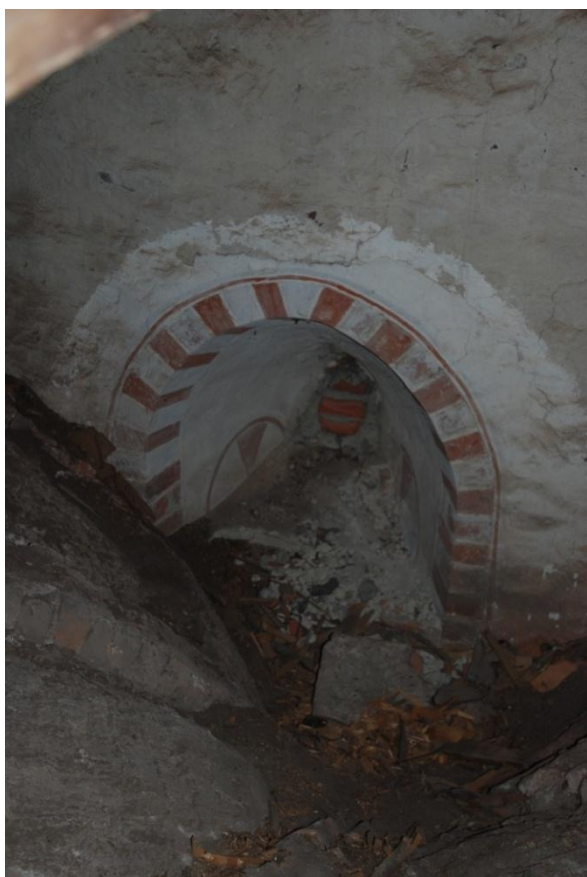
Fig. 6: Igensatt fönsteröppning i långhuset
