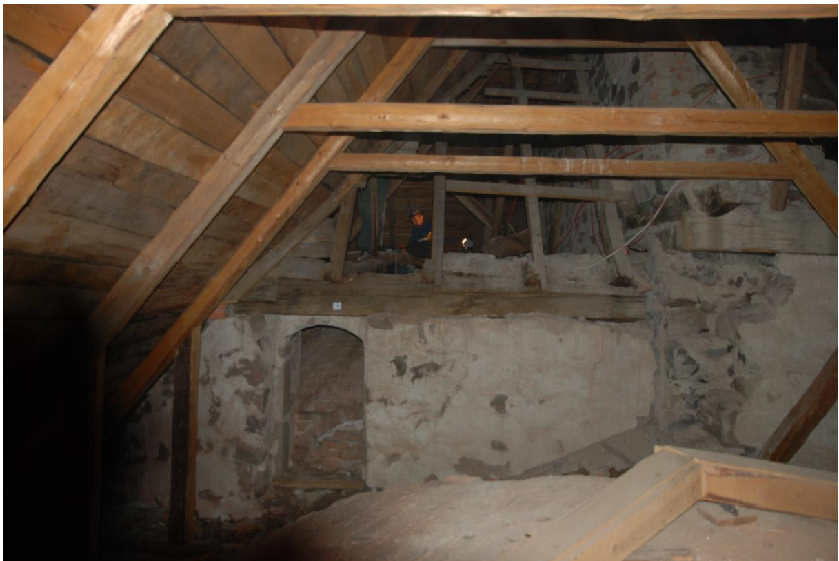
Fig. 10: Koret sett från sakristievalvet. Till höger långhusets östra gavelröste, påmuret med tegel i samband med takhöjning. Nere till vänster portalen mellan koret och sakristians övervåning.
