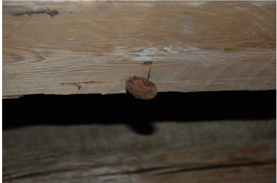
Fig. 9: Spikhuvud på undersidan av bindbjälke i koret
