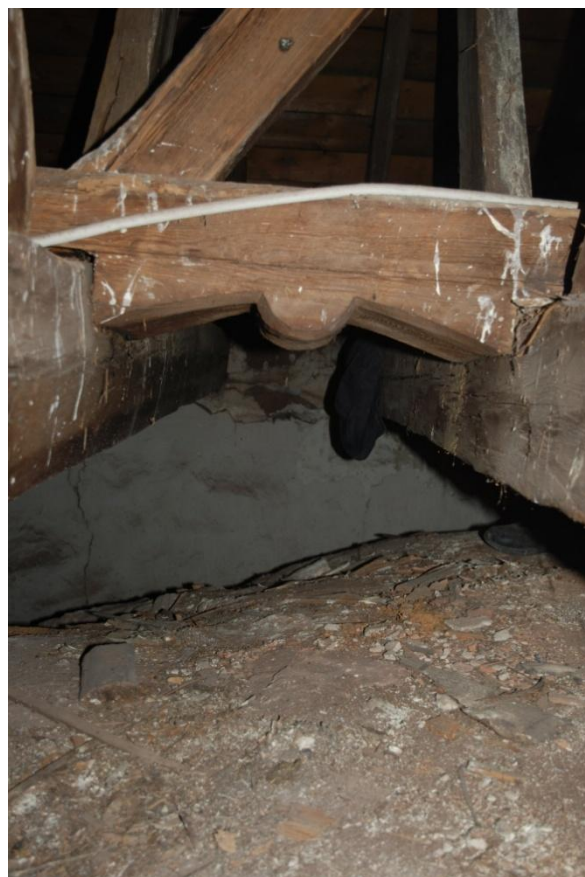
Fig. 7: Ornerad styrbjälke till saxbenet i koret
