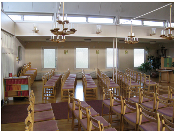
Kyrkorummet mot norr. Utmed långsidorna sitter enlufts-fönster med aluminiumbågar och råglas. Överst i bild syns de ursprungliga fönstren i mittskeppets vertikala fasadparti.
