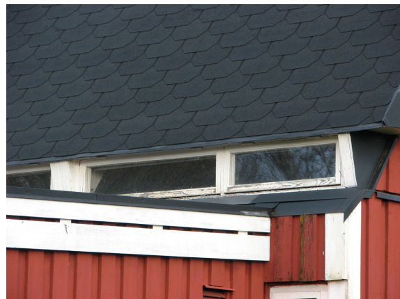
Mittskeppets vertikala fasadpartier utmed långsidorna har en rad av liggande enluftsågar, ursprungliga.
