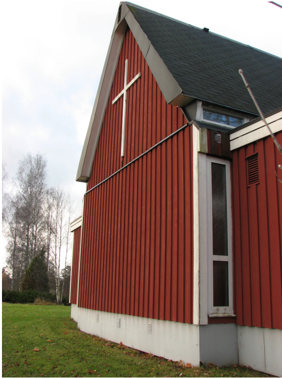
Östra fasaden med korfönster.
