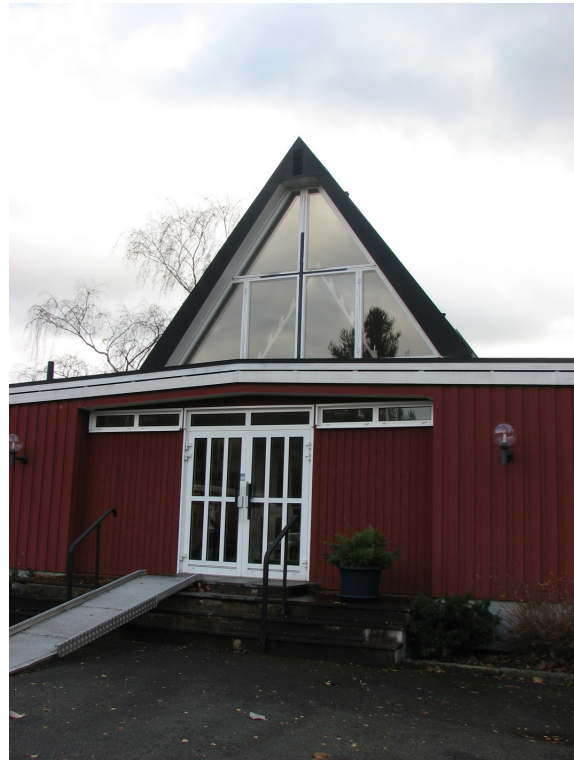
Västfasaden med huvudentré. Det västra gavelröstet är försett med stora öppningsbara fönster, original, på vars karm ett kors är målat i svart.
